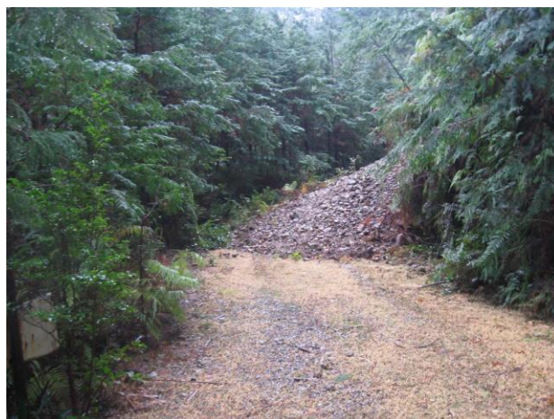
図 3 初代坂下隧道西側にて土砂崩れで埋まる路盤
