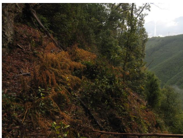
図 7 初代坂下隧道の東口すぐ先の路盤崩壊
