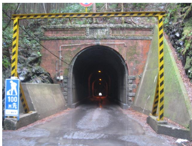
図 8 国道 425 号の二代目坂下隧道の西口坑門
